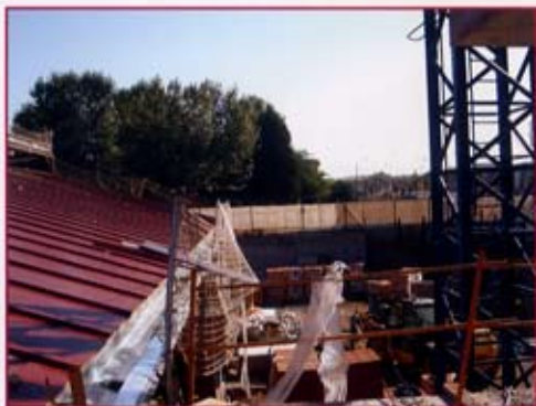
Red mal colocada
